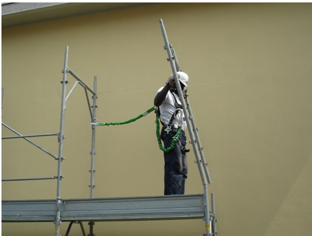
19) Assicurarsi al telaio successivo e proseguire la sequenza
