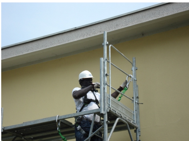
21) Montare il telaietto di testate e assicurarsi
