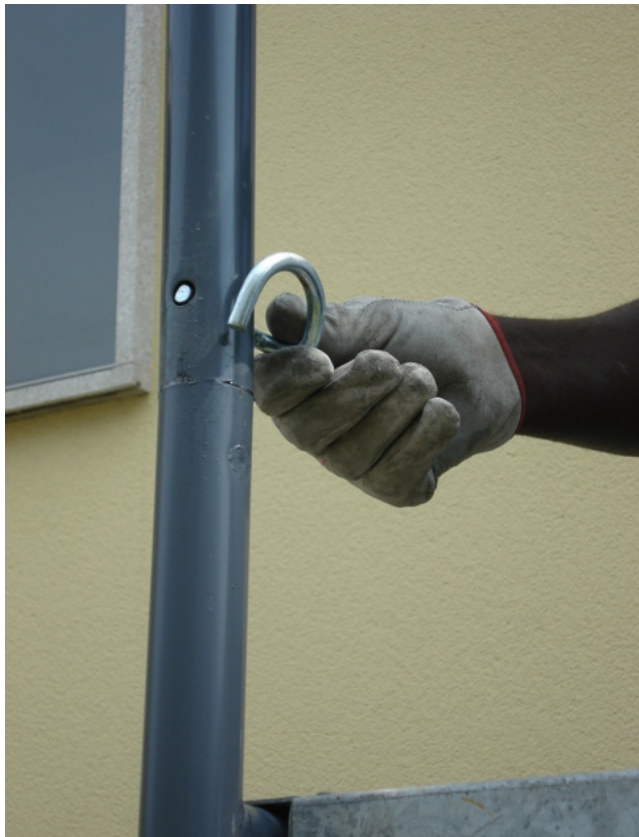
12) Collegare i telai tramite la spina a verme
