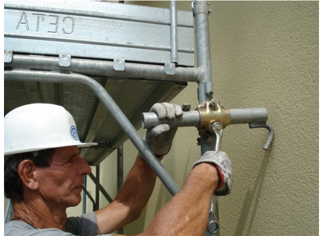
10) Montare gli ancoraggi al primo livello, secondo gli schemi del libretto di autorizzazione o come indicato nel progetto
