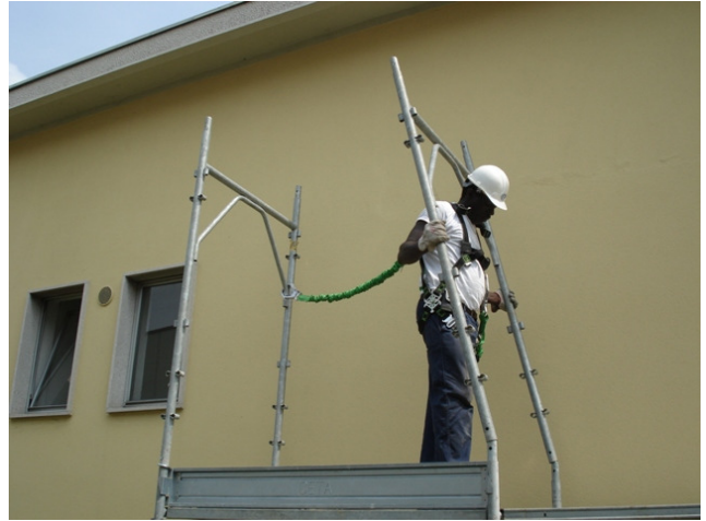
14) Infilare il telaio successivo
