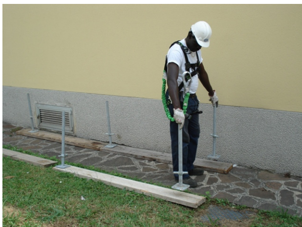
1) Posizionare le basette sulle tavole di ripartizione precedentemente disposte
