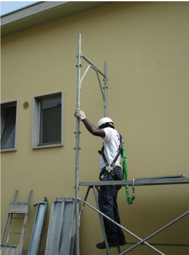
11) Assicurarli alla tavola con botola, salire al piano superiore e infilare il telaio
