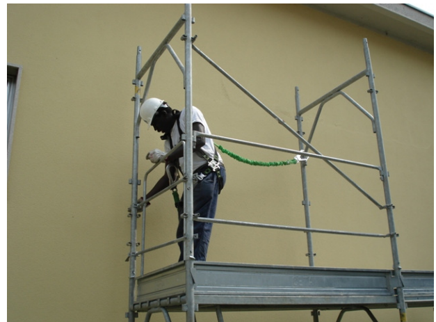
18) Montare il telaietto di testata
