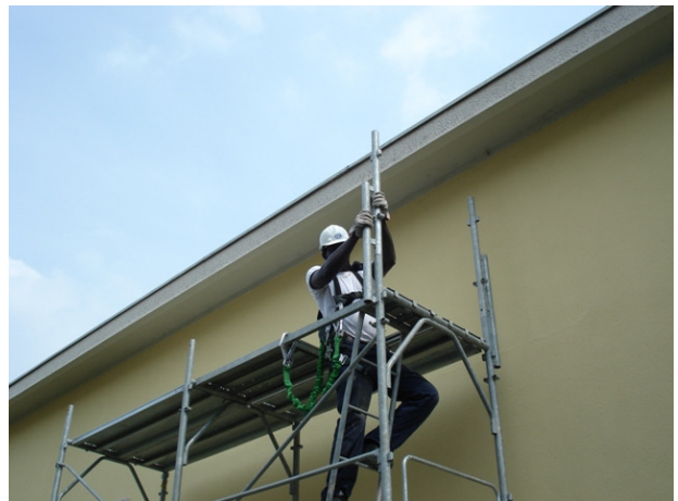
20) ULTIMO PIANO Assicurarsi alla tavola con botola, salire all'ultimo piano e infilare le aste di parapetto
