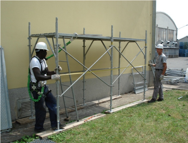
9) Allineare i telai e fissare le basette alle tavole in legno sottostanti
