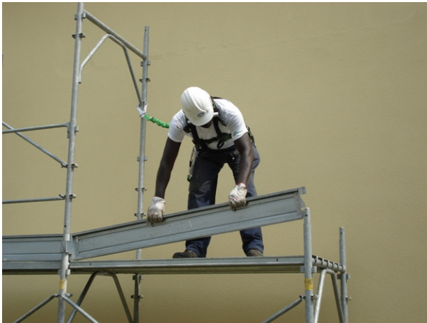
15) Completare l'impalcato con il fermapiede
