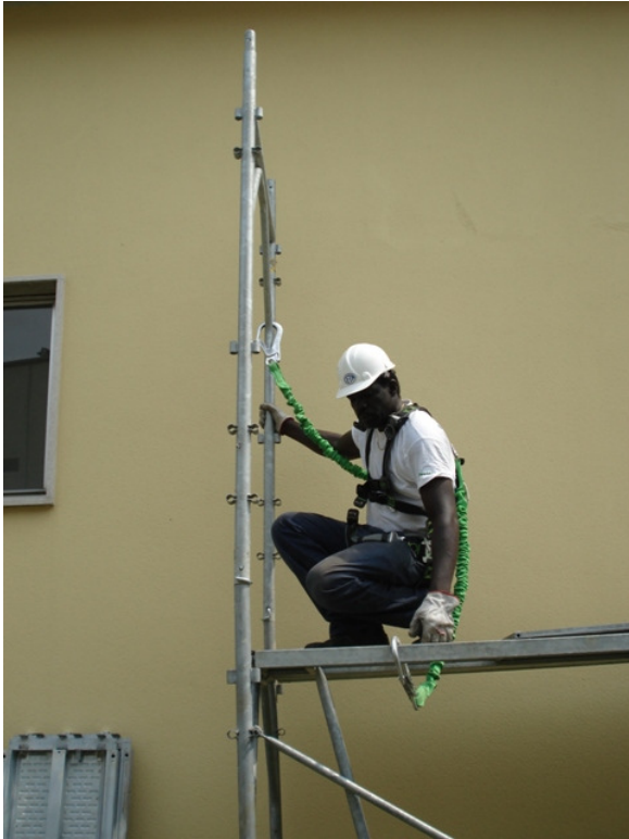
13) Assicurarsi al telaio montato e chiudere la tavola con botola
