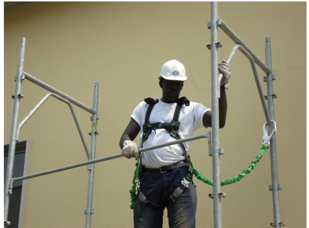
16) Montare i correnti
